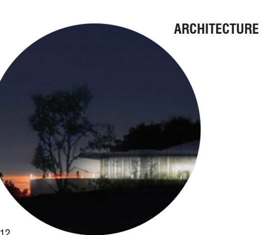
2012 Centre scolaire de Ploeren, Concarneau, FR MARC MIMRAM
