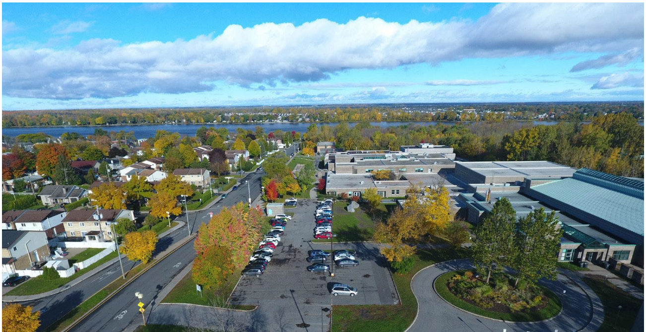
Vue aérienne vers la rivière – au-dessus de la bibliothèque (source : Ville de Montréal 2018)
