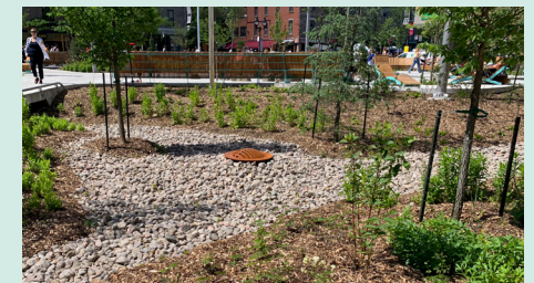
Jardin de pluie avec trop-plein
