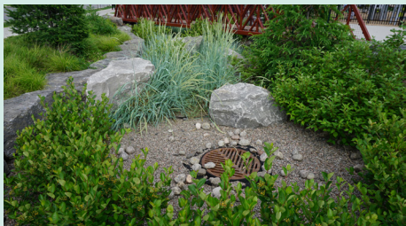
Noe de biorétention avec trop-plein
