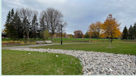
Rigole empierrée vers le ruisseau sec
