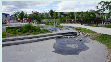
Puisard connectant les jeux d'eau aux jardins de pluie
