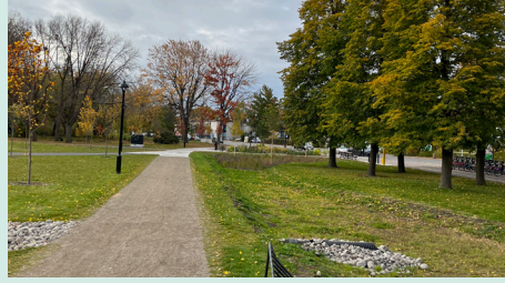
Fin de la rigole empierrée vers le ruisseau sec
