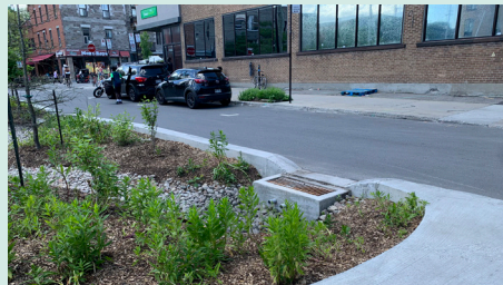
Abaissement de bordure avec capteur à sédiments
