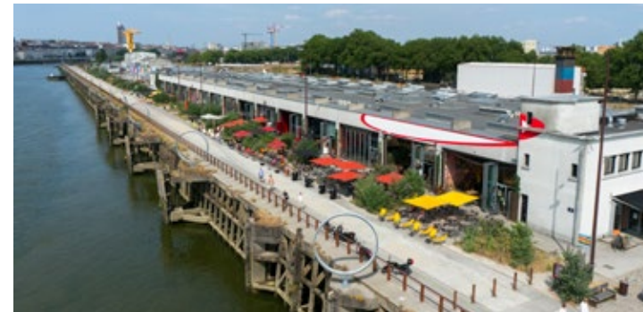
Quai des Antilles. Hangar à bananes, par Agence Rouleau architectes urbanistes © Valéry Joncheray/Samoa
