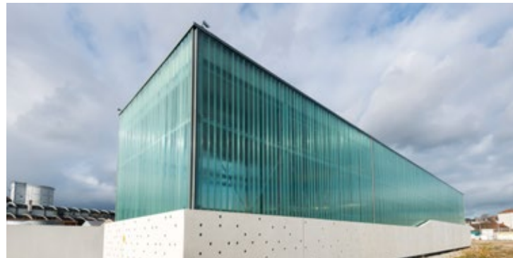
Poste source Erdf., architecture par Darzonval © Valéry Joncheray/Samoa
