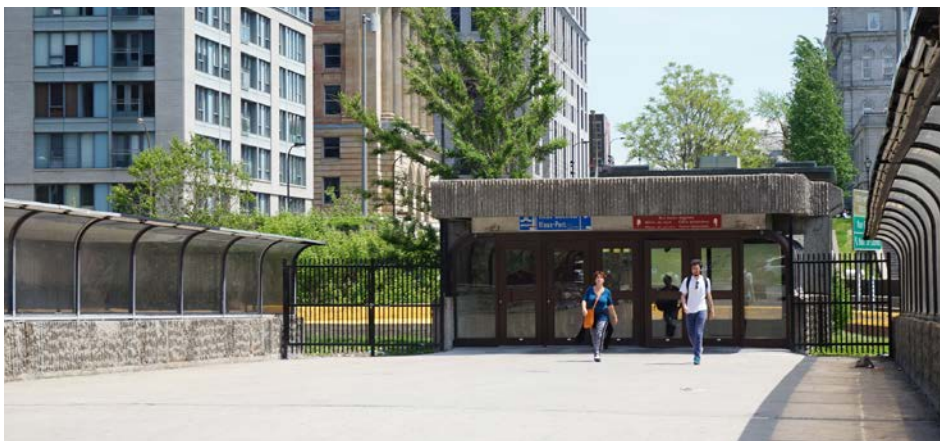
PASSERELLE PIÉTONNE MENANT AU TUNNEL CHAMP-DE-MARS
