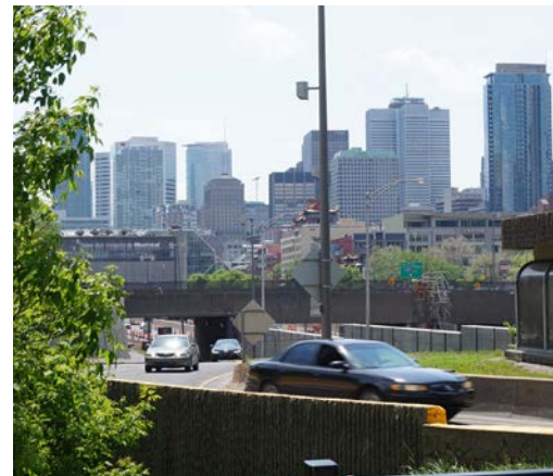
BRETELLE DE SORTIE SANGUINET DE L'AUTOROUTE VILLE-MARIE
