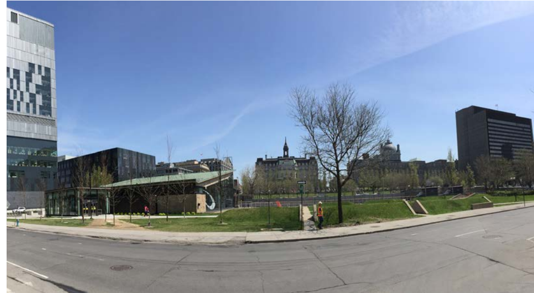
VUE PANORAMIQUE DE LA CITÉ ADMINISTRATIVE
