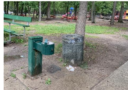
Figure 29 : Exemples de mobilier désuet à remplacer : estrade en bois, fontaine à boire et poubelle en béton
