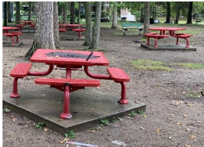
Figure 24 : Mobilier non accessible avec base de béton surélevée
