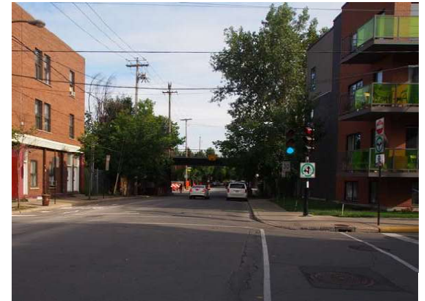
Vue sur le viaduc ferroviaire à partir de la rue d'Hibernia
