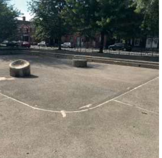
PATAUGEoire EN BÉTON
