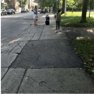
RÉPARATION DE TROTTOIR
