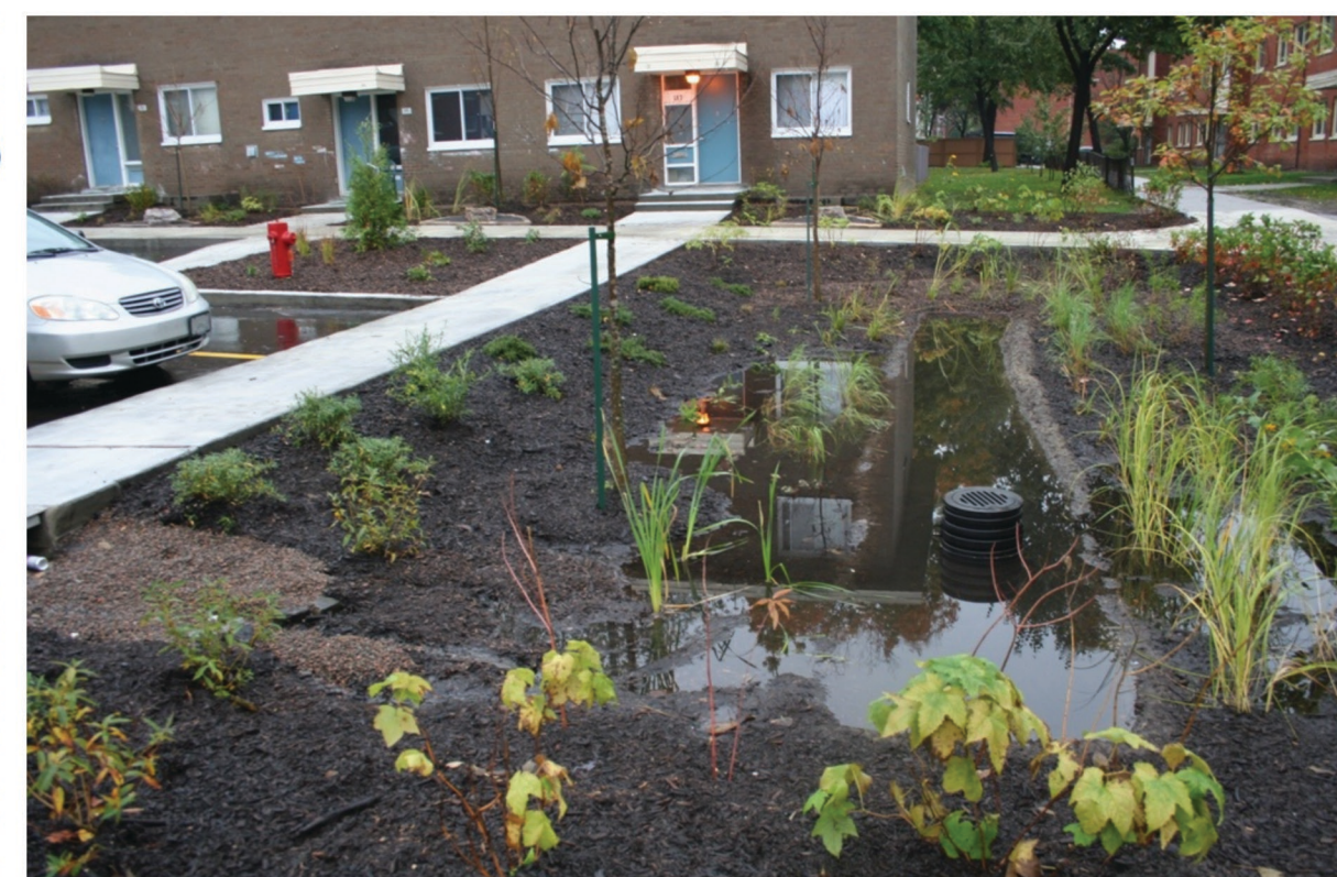
Biorétention et lit d'infiltration Corporation d'habitations Jeanne-Mance, Montréal (source: exp)
