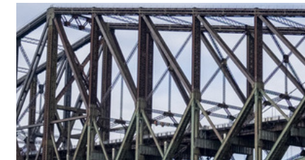
Structure de pont
