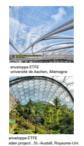
enveloppe ETFE université de Aachen, Allemagne enveloppe ETFE eden project, St. Austell, Royaume-Uni
