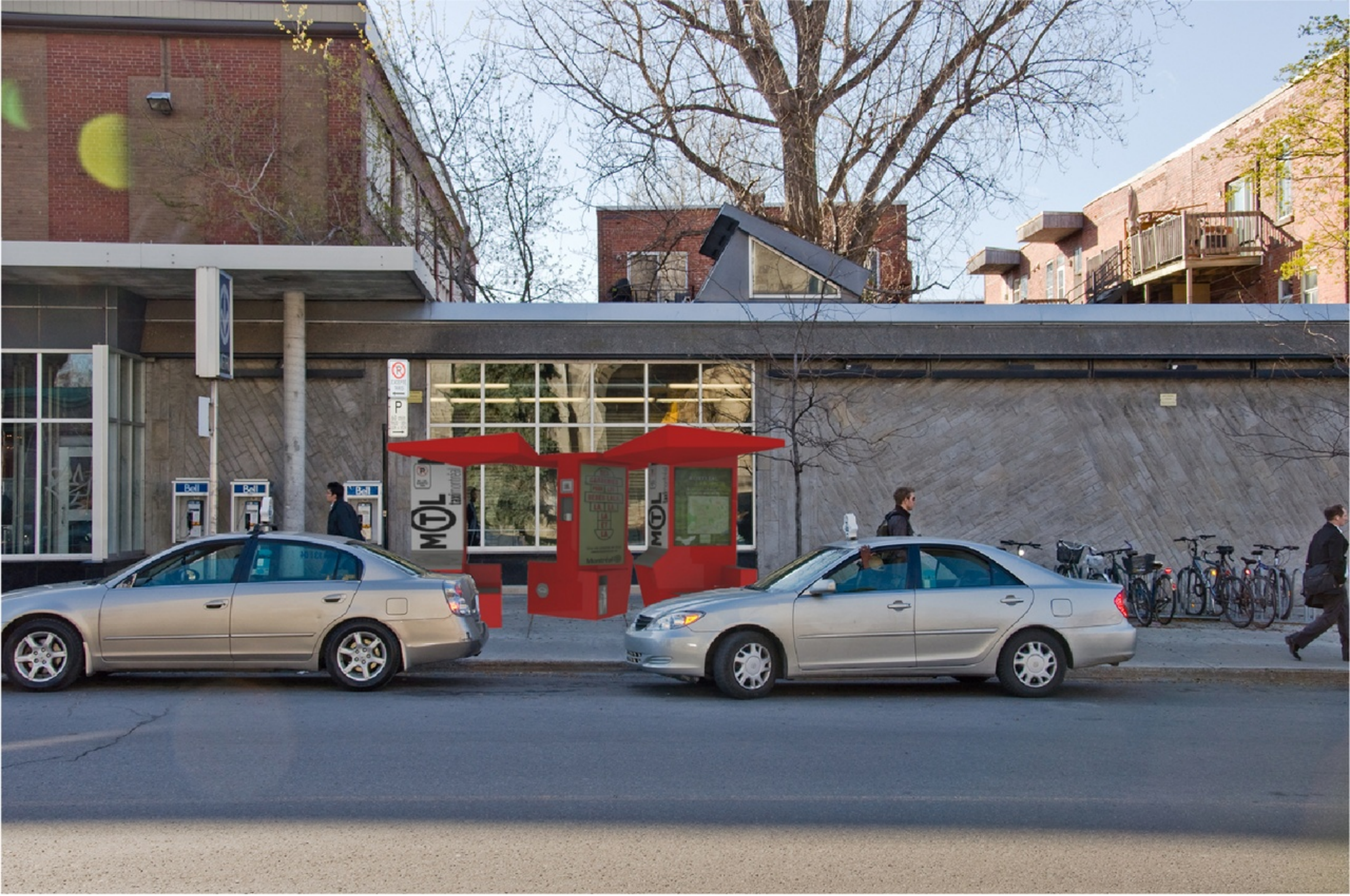
intégration dans le paysage urbain - 2 / 3
