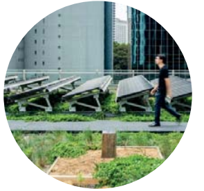
Panneaux solaires Daramu House Sydney
