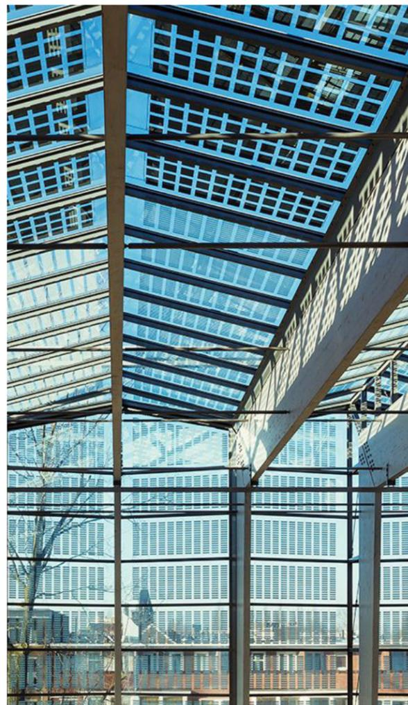
Toit de panneaux solaires, station centrale de Rotterdam Central Station par MVSA, Rotterdam, Pays-Bas (photo : MVSA)
